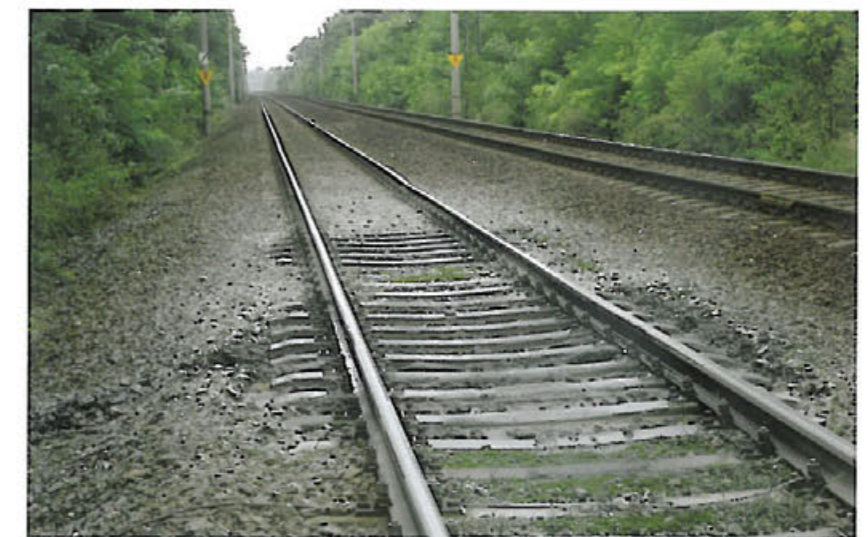
1. kép. Sáros ágyzat, sebességkorlátozás a 304+95 szelvényben (Fotó: Balogi András)
